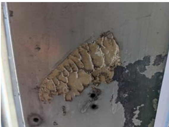
CHE-CNW11097-140721-007 thru 009, Asbestos Not Detected, Beige mastic
