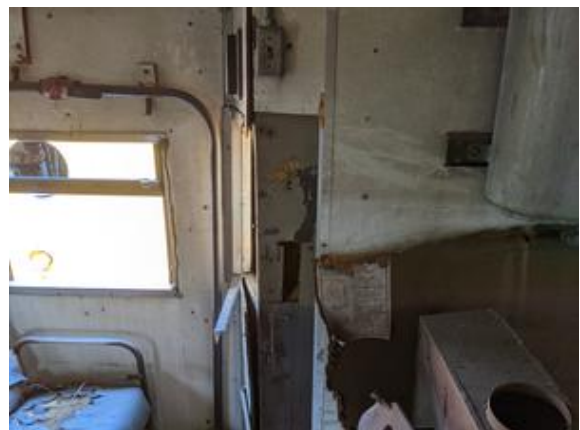
CHE-CNW11097-140721-007 thru 009, Asbestos Not Detected, Beige mastic
